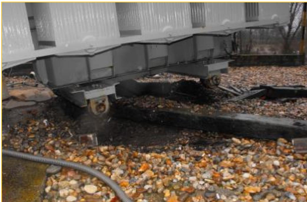
Fotografía: Vertido de aceite térmico de transformador
